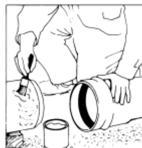
Slika 2. Namazati ukošenje na kraju cijevi odgovarajućim kliznim sredstvom podesnim za PVC cijevi
