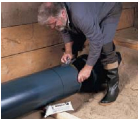
Slika 1. Očistiti skošenje na kraju cijevi i namazati mazivom koje je podesno za plastične cijevi
